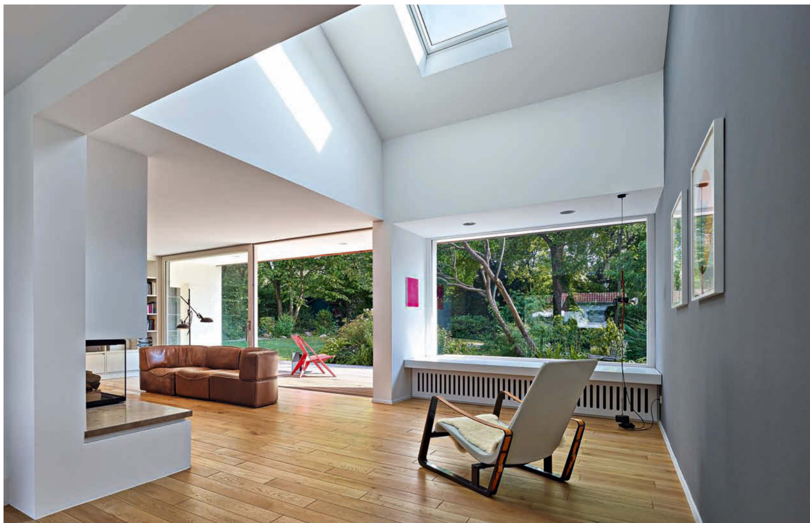
Durch das Öffnen der Decke bis unter die geneigte Dachfläche und durch das Entfernen von Zwischenwänden ... • By opening up the ceiling all the way to the inclined roof area and removing partition walls...
