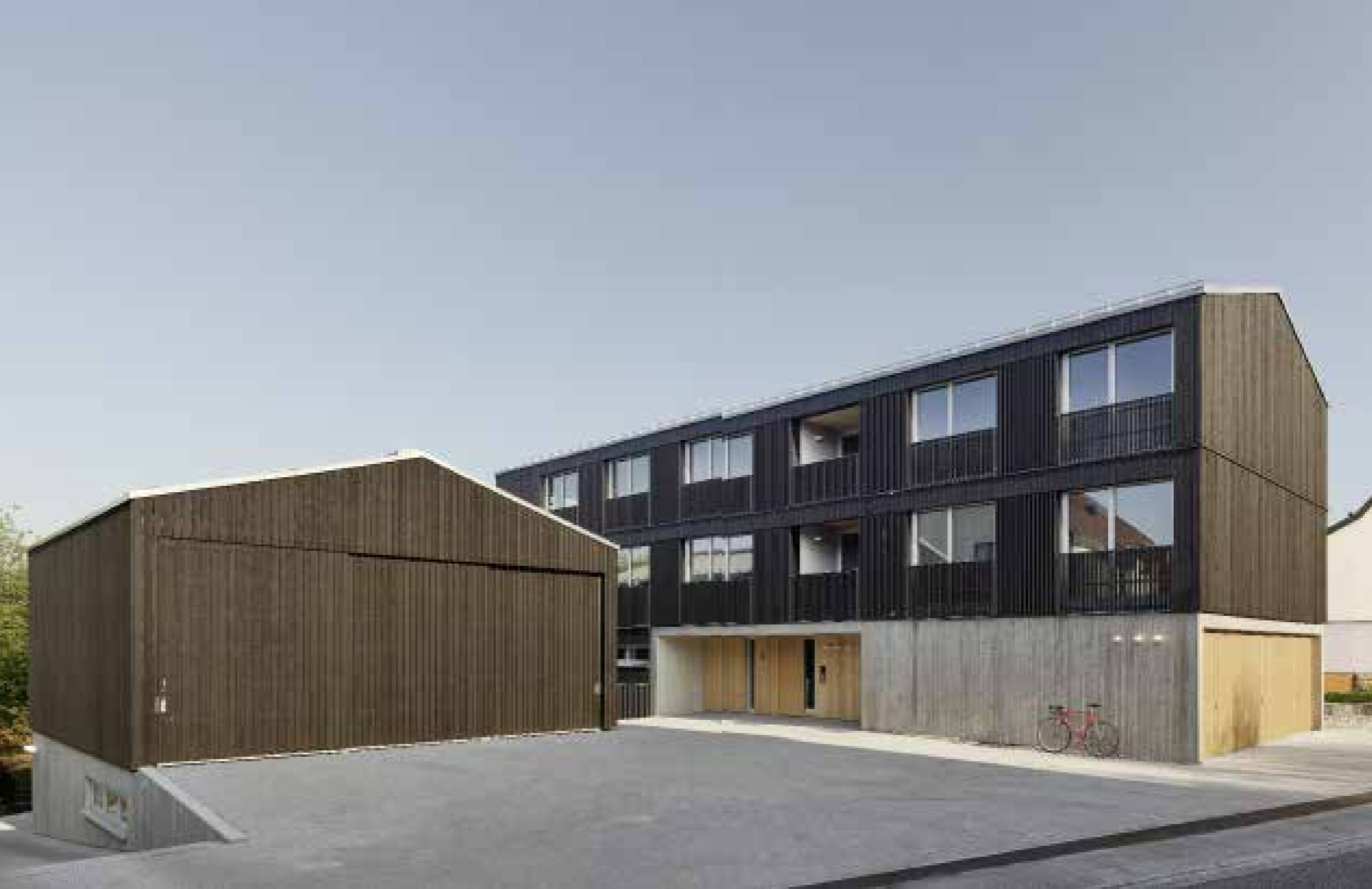
Die Holzrahmenbauten von Werkstatt und Mietshaus ruhen auf einem gemeinsamen Betonsockel.
