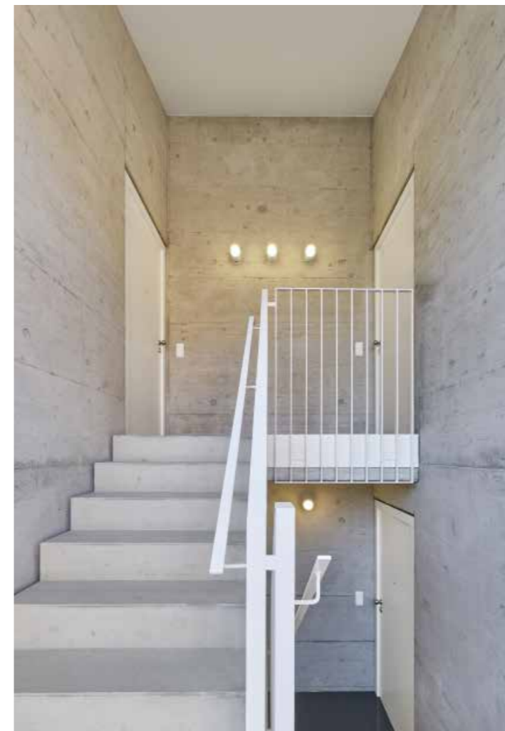
Der Sichtbeton zieht sich vom Sockel hinauf ins Treppenhaus.
